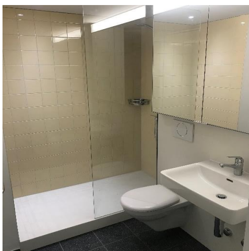
Badansicht nach Sanierung
