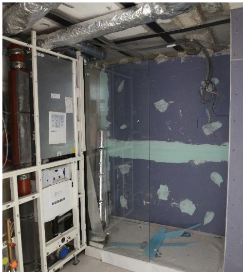
Thermos Element im Rohbau (eingebaut)
