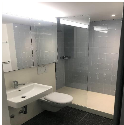
Badansicht nach Sanierung
