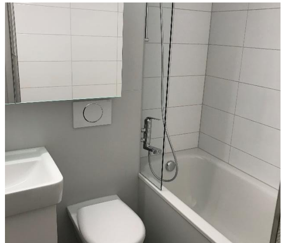
Saniertes Bad Typ Decora
