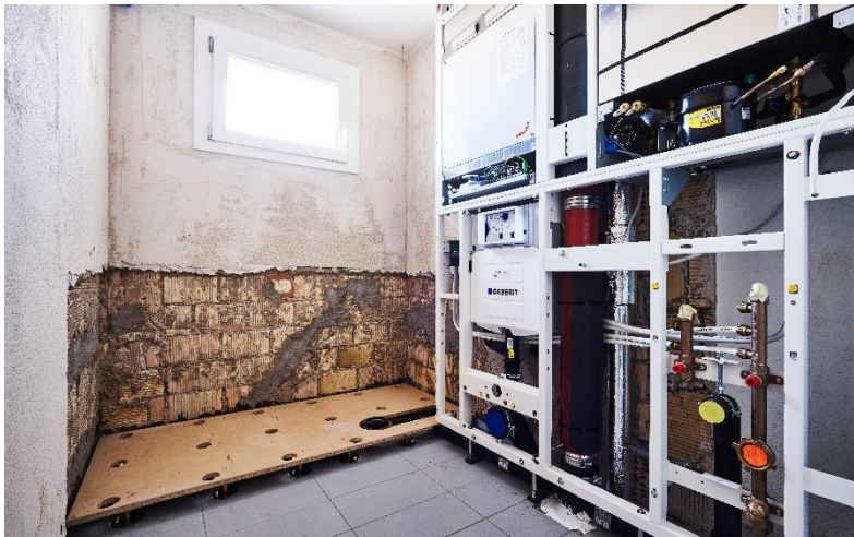
Der Vorteil ist der praktische Einbau der Swissframe-Module
